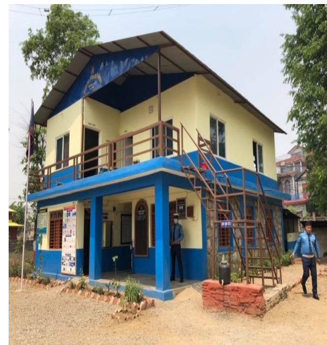
ग.प्र.ट्रा.प्र.का. का ट्रस निर्माण
